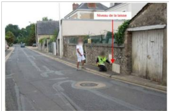
Repère de 2001 (source : CEREMA, 2008)
