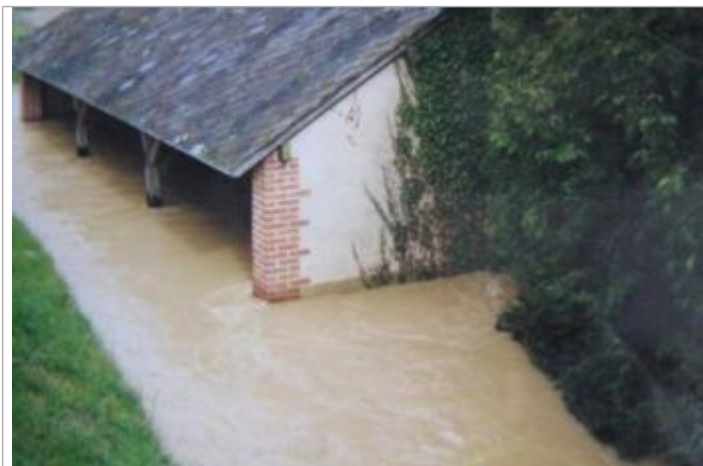
Repère de 2001 (source : CEREMA, 2008)
