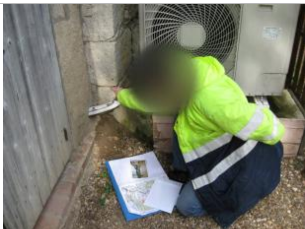
Repère de 2001 (source : CEREMA, 2008)
