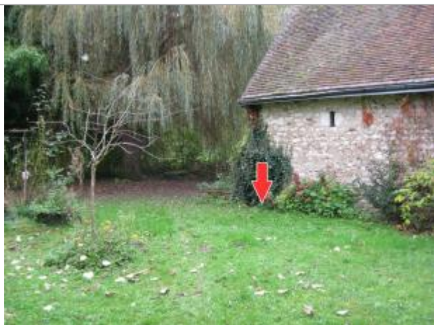
Repère de 2001 : 5 cm au-dessus du terrain naturel (source : CEREMA)
