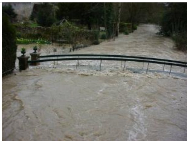
Photo prise vers 12h40, à peu près 1 heure avant le maximum de la crue (source : CEREMA)
