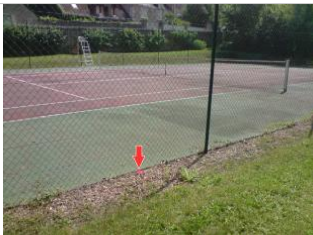
Laisse de crue : 30 cm au-dessus du terrain naturel (source : CEREMA)
