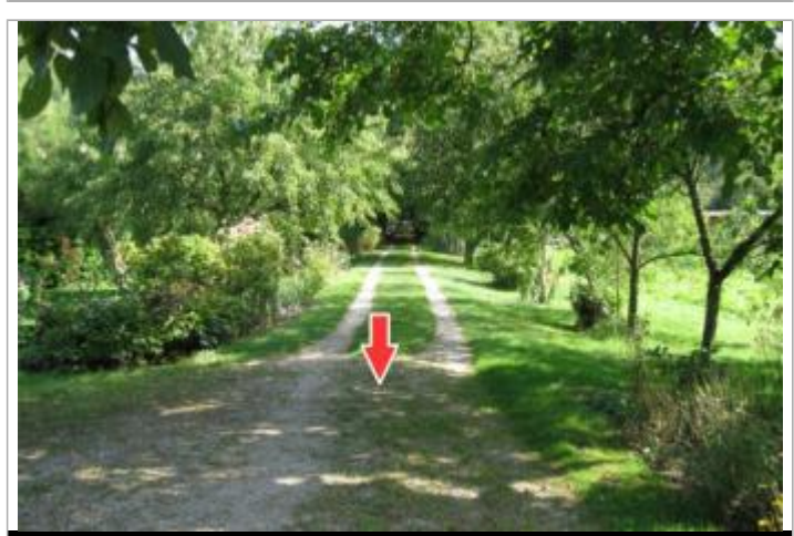
Repère de 2001 au niveau du remblais de l'ancienne voie de chemin de fer (source : CEREMA)
