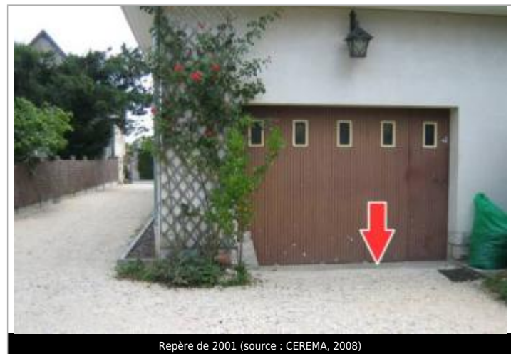
Repère de 2001 (source : CEREMA, 2008)
