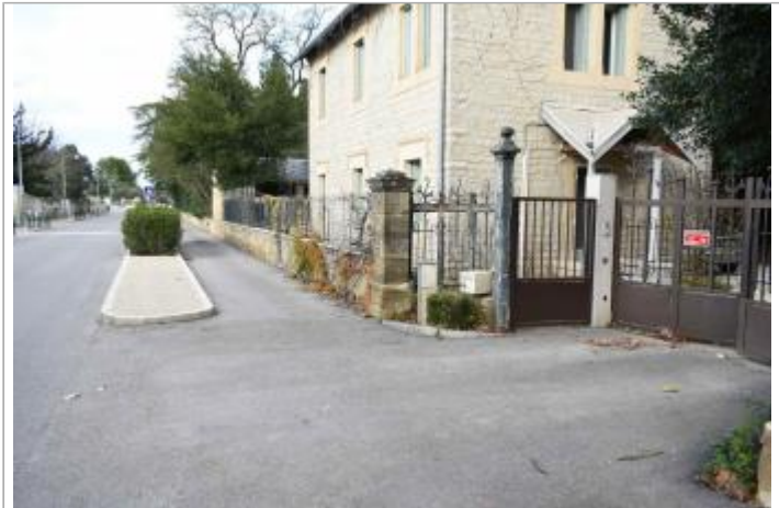
Vue d'ensemble du site. Repères sur le pilier du portail.
