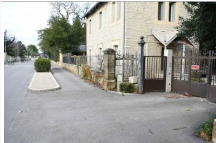
Vue d'ensemble du site. Repères sur le pilier du portail.
