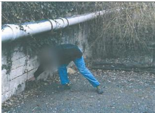
Vue du repère (source : CETE Normandie-Centre)
