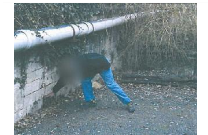
Vue du repère (source : CETE Normandie-Centre)
