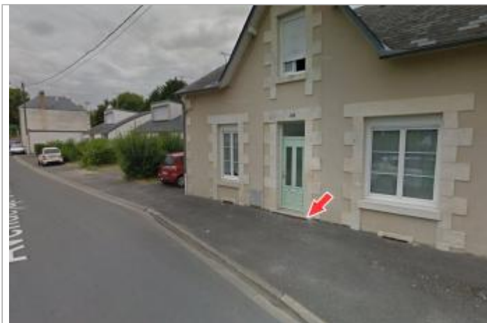
Site (source : Google Street View, juillet 2016)
