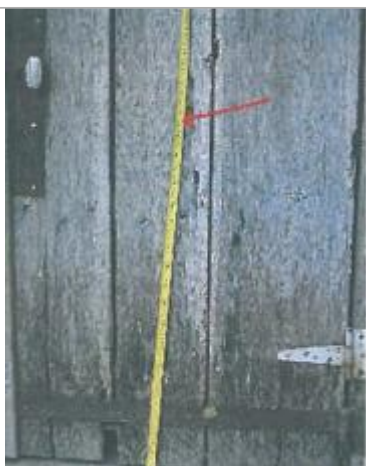
Vue du repère (source : CETE Normandie-Centre)
