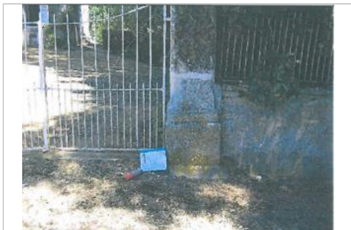
Vue du repère (source : CETE Normandie-Centre)
