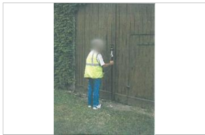
Vue du repère (source : CETE Normandie-Centre)
