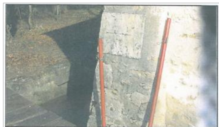
Vue du repère (source : CETE Normandie-Centre)
