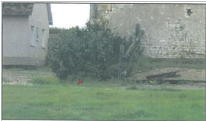
Vue du repère (source : CETE Normandie-Centre)
