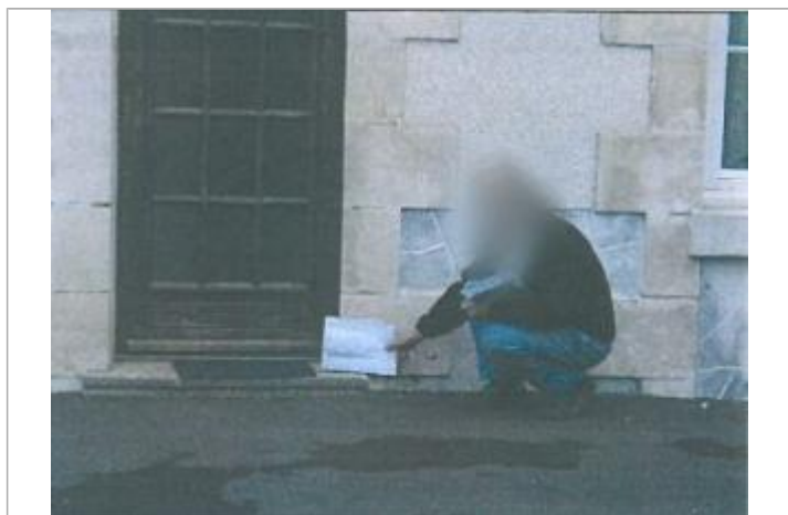
Vue du repère (source : CETE Normandie-Centre)
