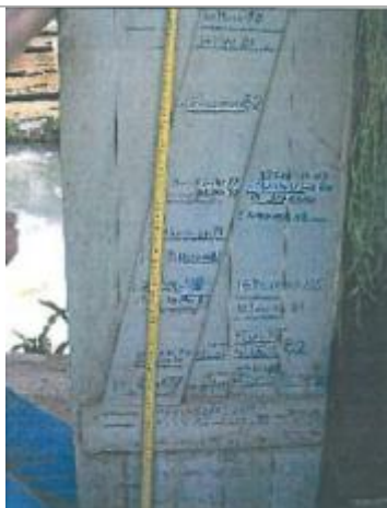
Vue du repère (source : CETE Normandie-Centre)
