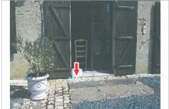
Vue du repère (source : CETE Normandie-Centre)
