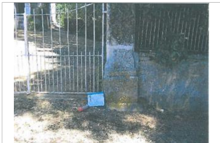
Vue du repère (source : CETE Normandie-Centre)
