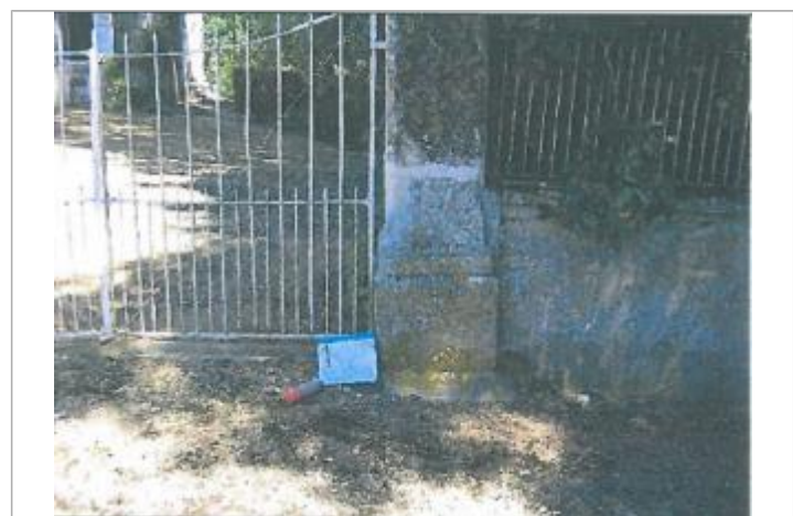
Vue du repère (source : CETE Normandie-Centre)
