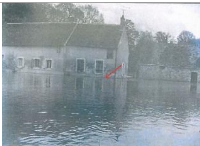
Vue du repère (source : CETE Normandie-Centre)
