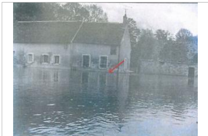
Vue du repère (source : CETE Normandie-Centre)
