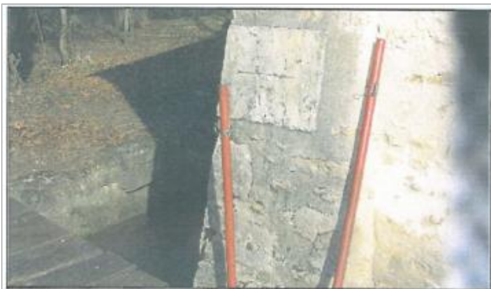
Vue du repère (source : CETE Normandie-Centre)
