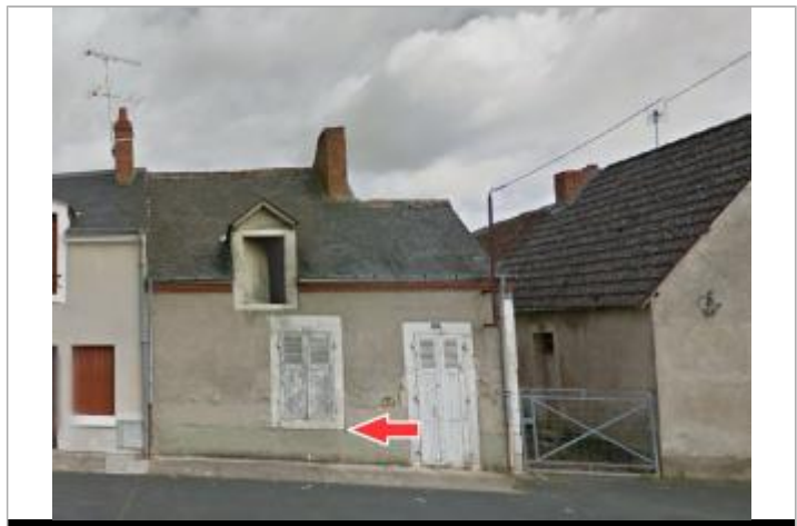
Vue du repère (source : CETÉ Normandie-Centre)
