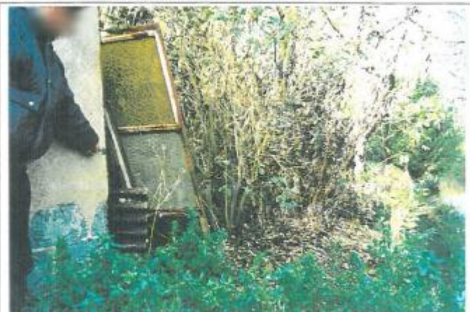
Site et repère de la crue de 1958 (source : COMIREM)
