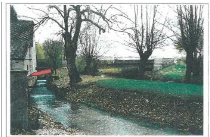
Site et repère de la crue de 1977 (source : COMIREM)
