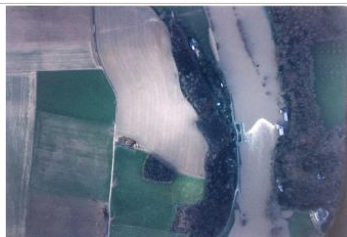
Vue de la crue
