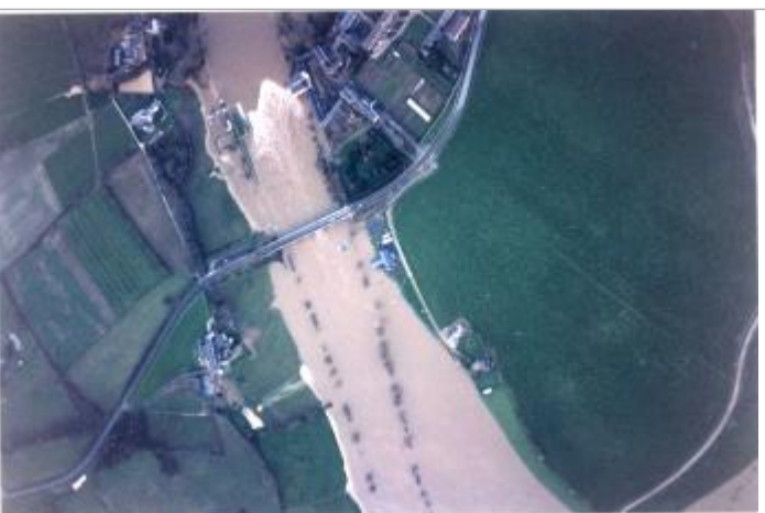
Vue de la crue
