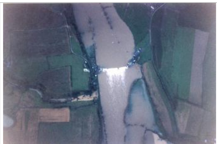
Vue de la crue
