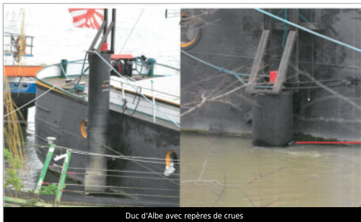
Duc d'Albe avec repères de crues
