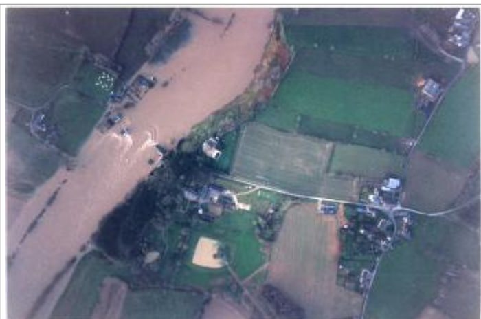
Vue de la crue
