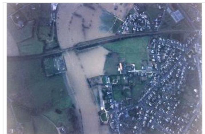
Vue de la crue
