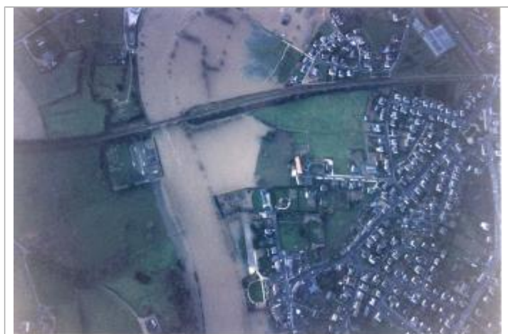
Vue de la crue
