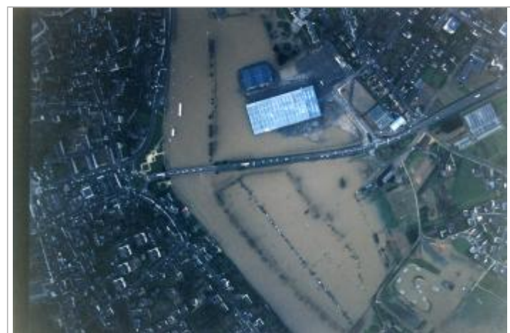
Vue de la crue
