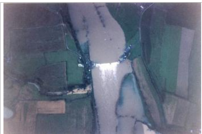
Vue de la crue
