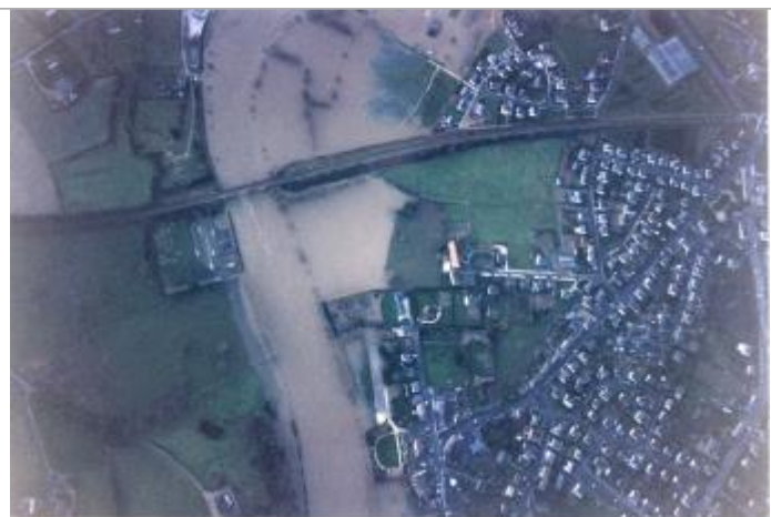
Vue de la crue
