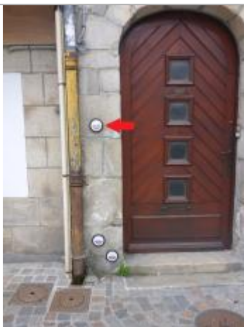
6, place Terre-au-Duc - crue de décembre 2000
