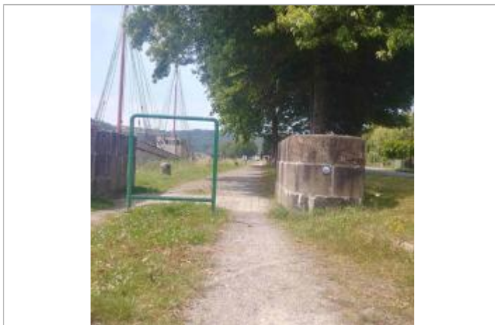
Pilier maçonné Quai Guilly Glas photo Anne Belleudy
