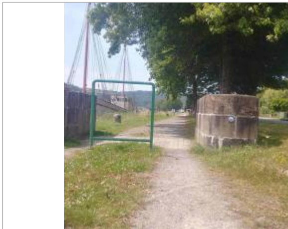
Pilier maçonné Quai Guilly Glas photo Anne Belleudy
