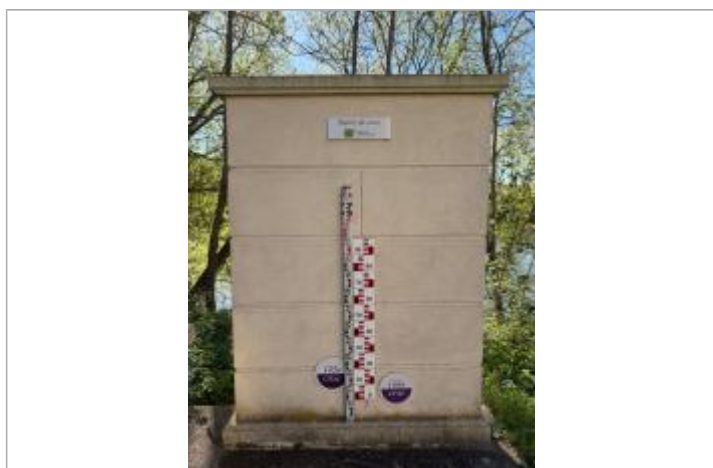
Vue de repères de crues
