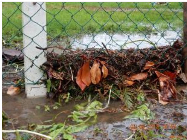
Zoom sur la base du poteau (source : SPC SACN)
