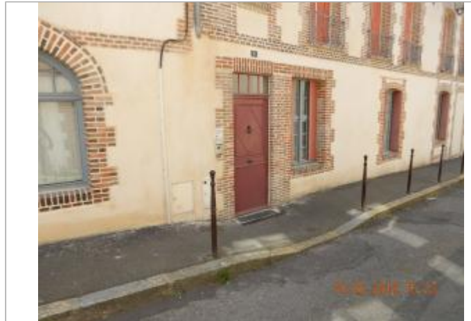
Porte d'entrée du 1 rue Désirée Marais (source : SPC SACN)
