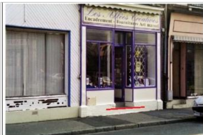
Photo du commerce en 2001, la ligne rouge indique le niveau d'eau atteint (source : BCEOM)
