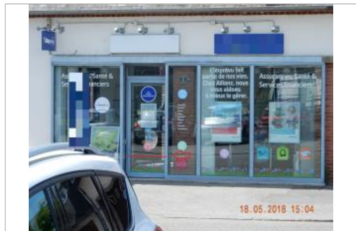
Le niveau d'eau maximum se situait 50 cm au-dessus du seuil de la porte (source : SPC SACN)
