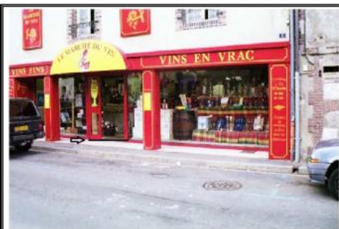
Le niveau d'eau a atteint le seuil de la porte d'entrée (source : BCEOM)
