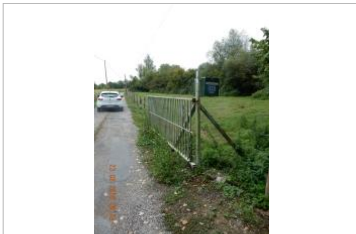
Photo du poteau soutenant le portail (source : SPC SACN)
