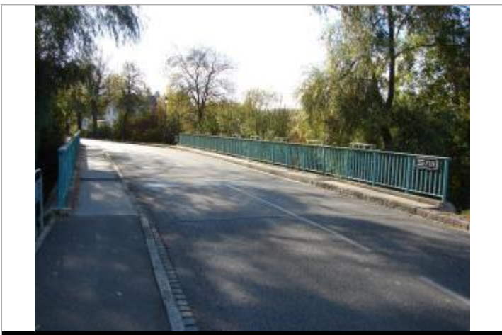
Vue générale du site
