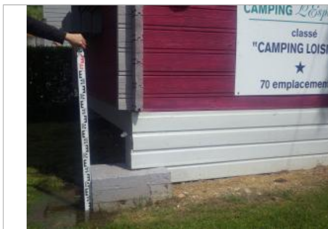
Mesure du niveau d'eau au pied du local (source : SIBVR)
