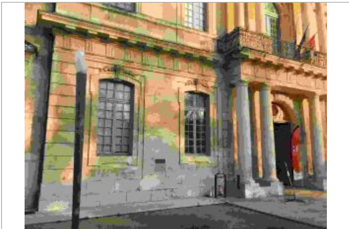
Vue du site
