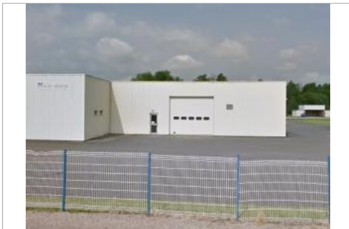
Photo de la partie du bâtiment du repère 1
