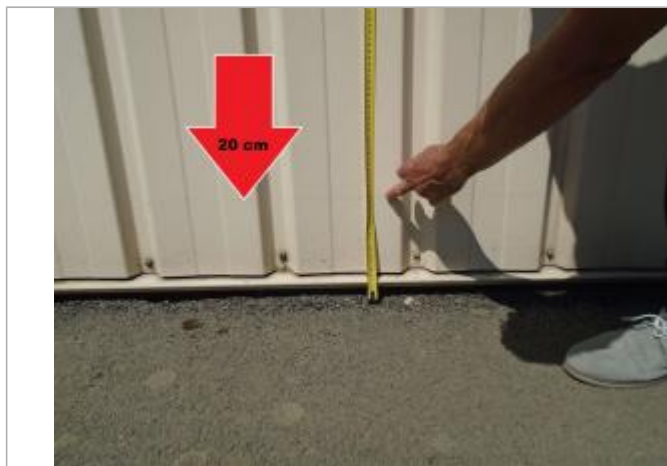
Bâtiment industriel situé rue du Général Leclerc (RD579A)
